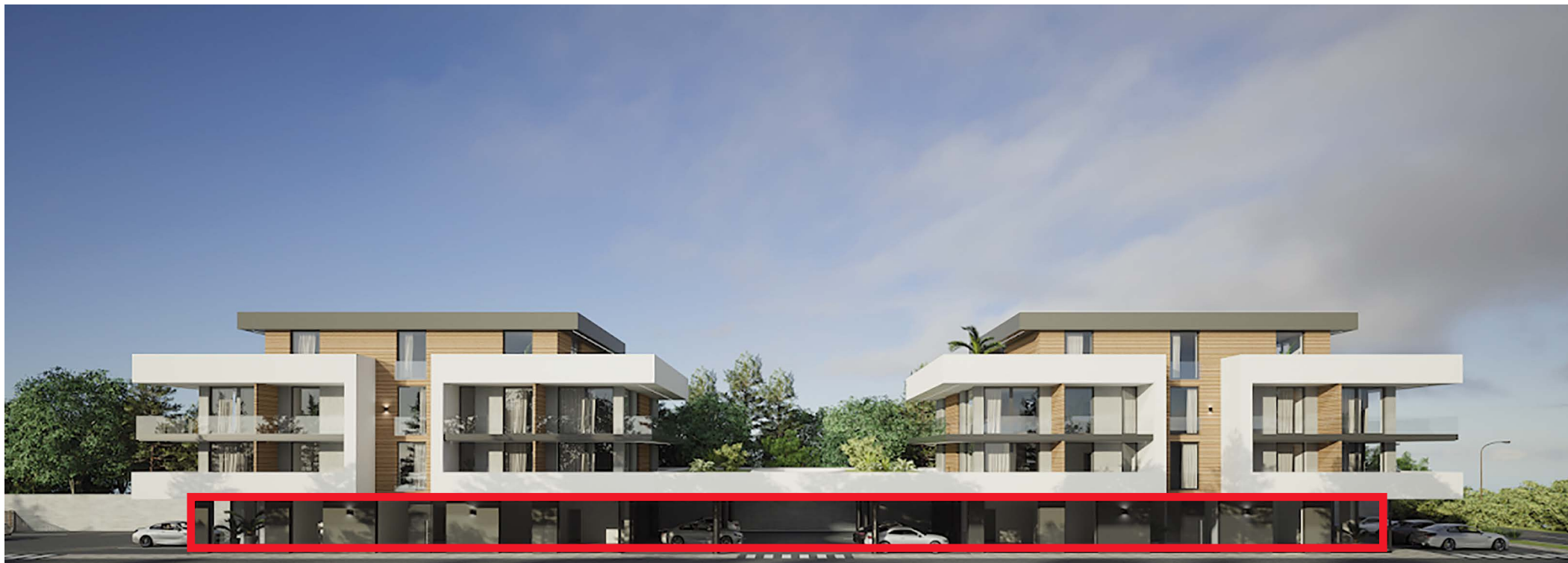
1. NP – Budova B
